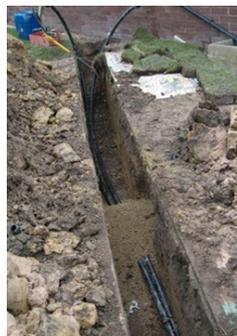
CORRECT GSHP TRENCH FOR LOOP & BACKFILL
